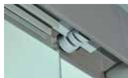
2 Sensoren voor detectie dwarschuifraam
